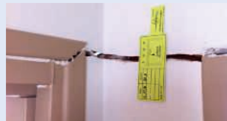
Rupture de la cloison entre deux portes avec déformation des encadrements.
