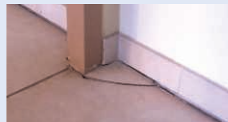
Tassement entraînant la rupture du carrelage
