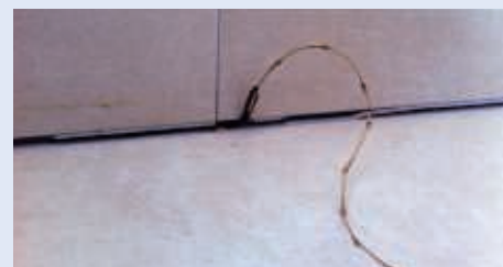
La végétation pousse entre les plinthes et le carrelage au niveau du tassement > 1 cm.
